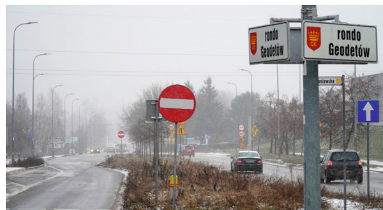
● Ulica Warszawska także zyska nową nawierzchnię na odcinku od ronda Geodetów do mostu na Silnicy.
