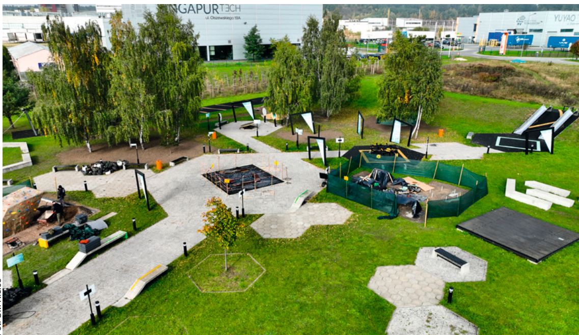
● Dzięki Budżetowi Obywatelskiemu rozbudowywany jest Energetyczny Ogród Doświadczeń. Powstanie m.in. ścianka wspinaczkowa i instrumenty muzyczne. A teraz mieszkańcy zdecydowali, żeby w Ogrodzie pojawiły się urządzenia dla dzieci z niepełnosprawnościami.
