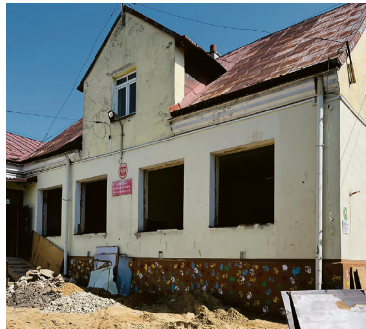
● Szkoła Podstawowa nr 4 zamieniła się w wielki plac budowy.
