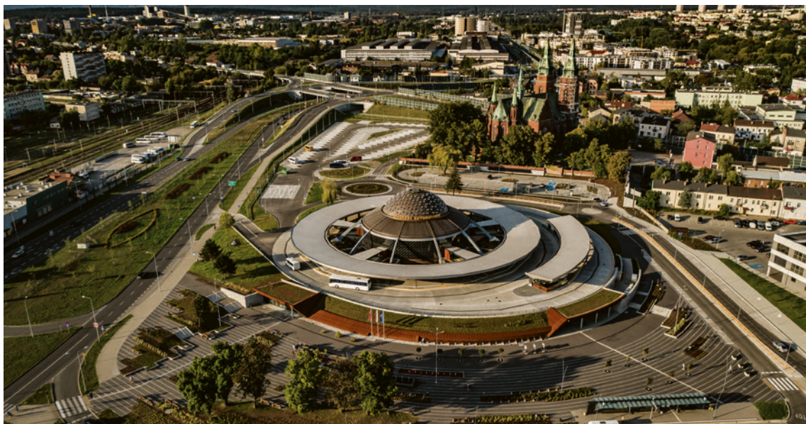
• Nowa droga dla rowerów powstanie m.in. wzdłuż ulic Zagnańskiej i Przemysława Gosiewskiego oraz ulicy Żelaznej. Dzięki temu powstanie bezproblemowy dojazd rowerem do dworców autobusowego i kolejowego.
