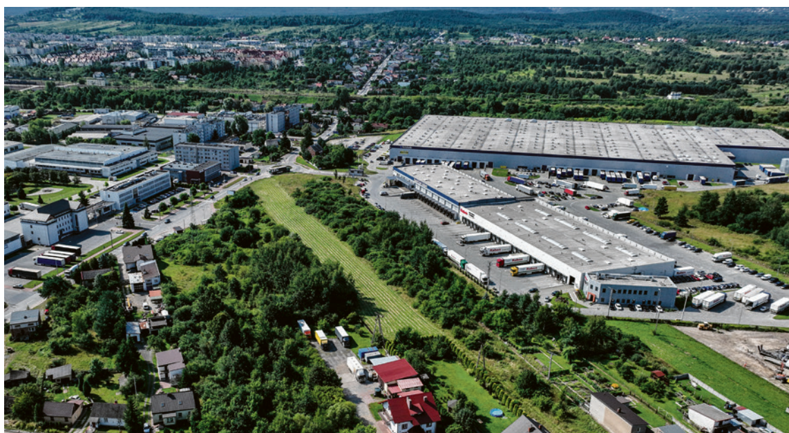
● Budowa ulicy Malików-bis to strategiczna inwestycja dla rozwoju Kielc. Dzięki tej inicjatywie otwartych zostanie ponad 40 hektarów nowych terenów inwestycyjnych.
