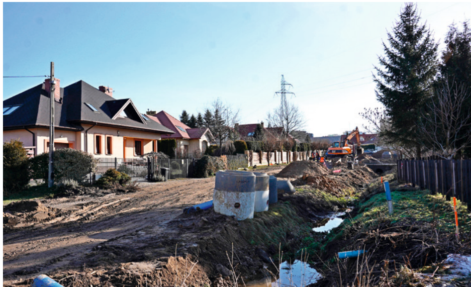
● Remont ul. Karczunek poprawi bezpieczeństwo i komfort wszystkich użytkowników drogi. Zanim powstanie jezdnia wykonana zostanie kanalizacja.
